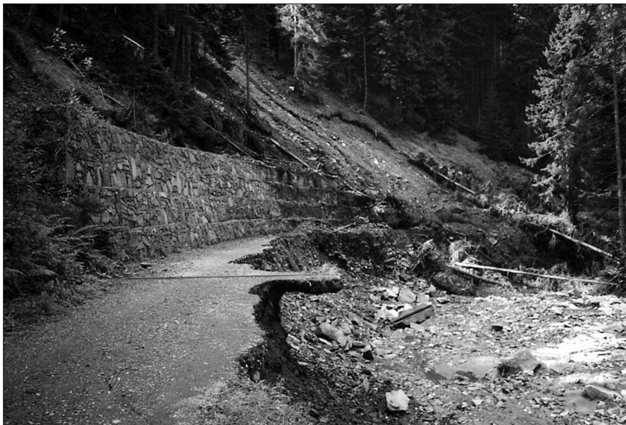
Obr. 10: Sjetá stráň, stromy v korytě, zničená lesní cesta – Černá voda. Foto: Radko Novotný
