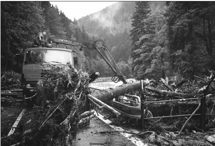
Obr. 15: Dramatické okamžiky na dolním toku Malé Úpy způsobilo zanesení mostku u Myslivny. Svou zápornou roli zde sehrál opěrný pilíř uprostřed oblouku řeky. Foto: Radko Novotný
