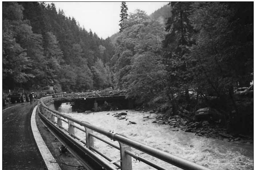
Obr. 15: Dramatické okamžiky na dolním toku Malé Úpy způsobilo zanesení mostku u Myslivny. Svou zápornou roli zde sehrál opěrný pilíř uprostřed oblouku řeky. Foto: Radko Novotný
