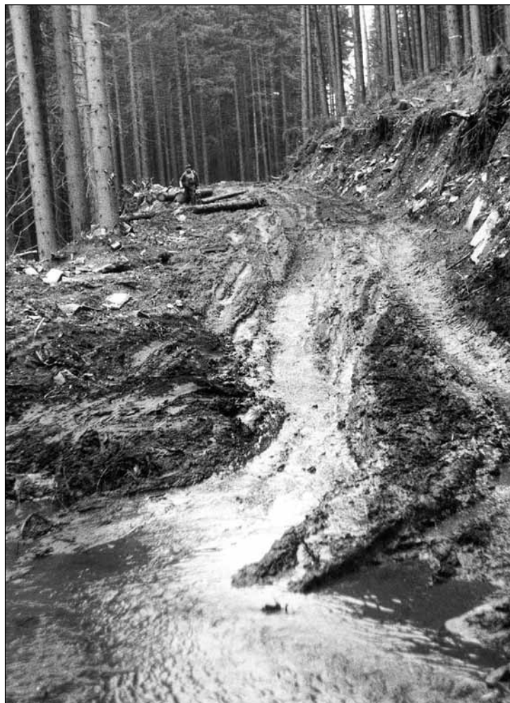
Obr. 17: Etážová svážnice ve výstavbě. Jeseníky 1992. Foto: Jaroslav Herynek
