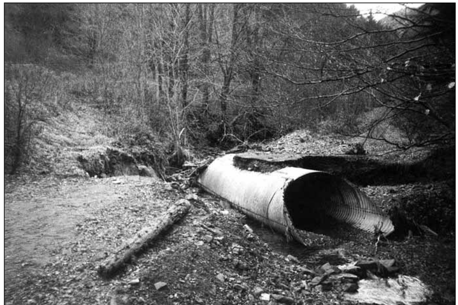
Obr. 20: Povodňové poškození trubní propusti Tubosider. Beskydy 1997. Foto: Jaroslav Herynek
