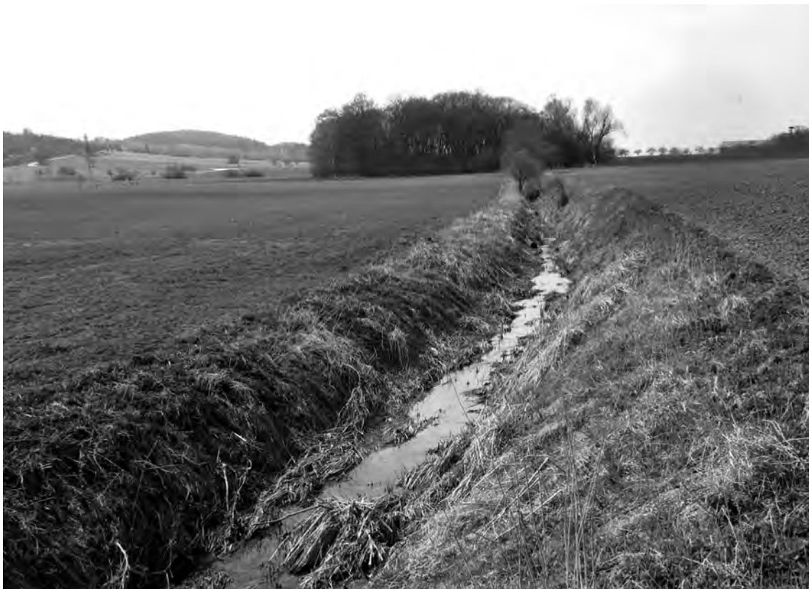
Obr. 5: Odvodňovací příkop s chybějícími břehovými porosty. Čejkovice okr. Jičín
