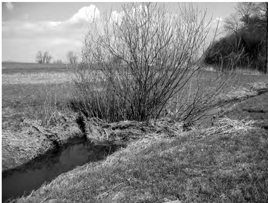
Obr. 4: Zácpa vodního toku způsobená nevhodně rostoucím stromem v korytě VT
